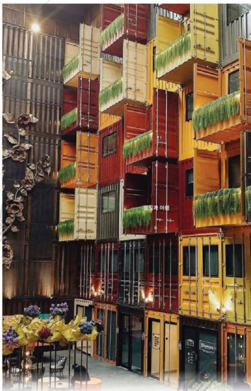
QUBIKA BOUTIQUE HOTEL - BSD TANGERANG
