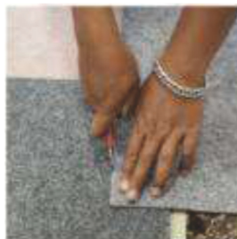
Untuk mempermudah proses pemotongan buat garis tanda untuk bagian karpet tile yang ingin dipotong
