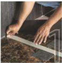
Pasang isolasi kertas di atas permukaan lantai
