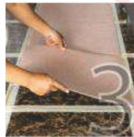
Tempel karpet tile di atas isolasi kertas yang telah diberi perekat
